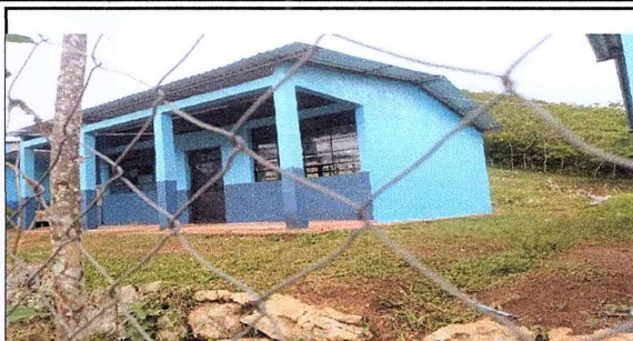
Foto1: Aula 1. Primero, Segundo, Tercero. Sustitución de vidrios y estructura de techo
