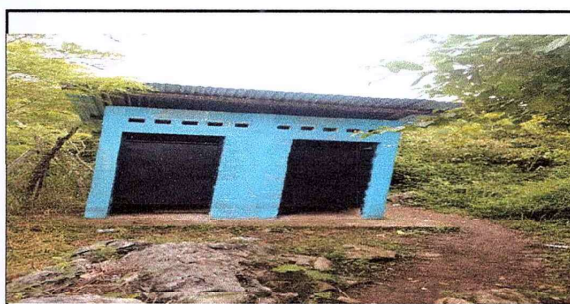
Foto 6: Reparación de sanitarios
