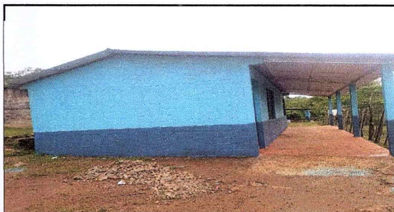
Foto 4: Aula 2. sustitución de costanera y mantenimiento de puertas.
