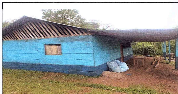
Foto 3: Sustitución de piso de cocina
